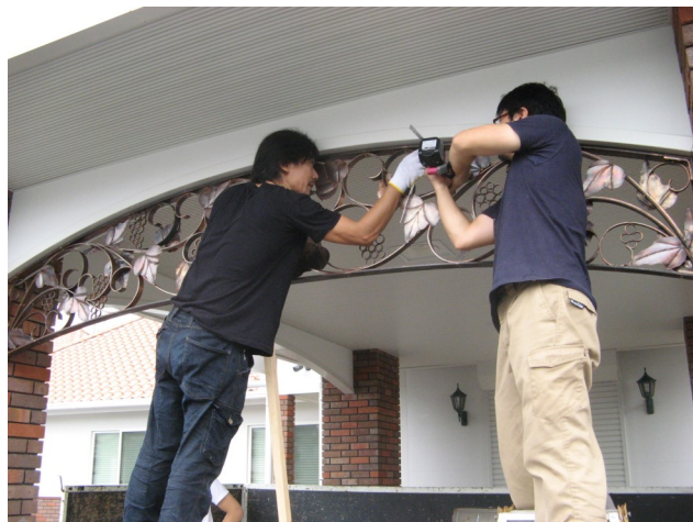
・銅製オーナメントの取り付け
